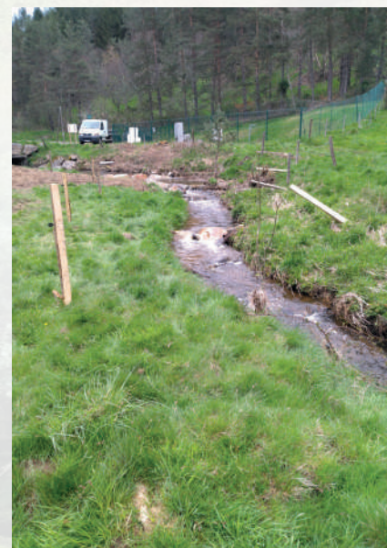
Pré-seuils en aval de la buse
